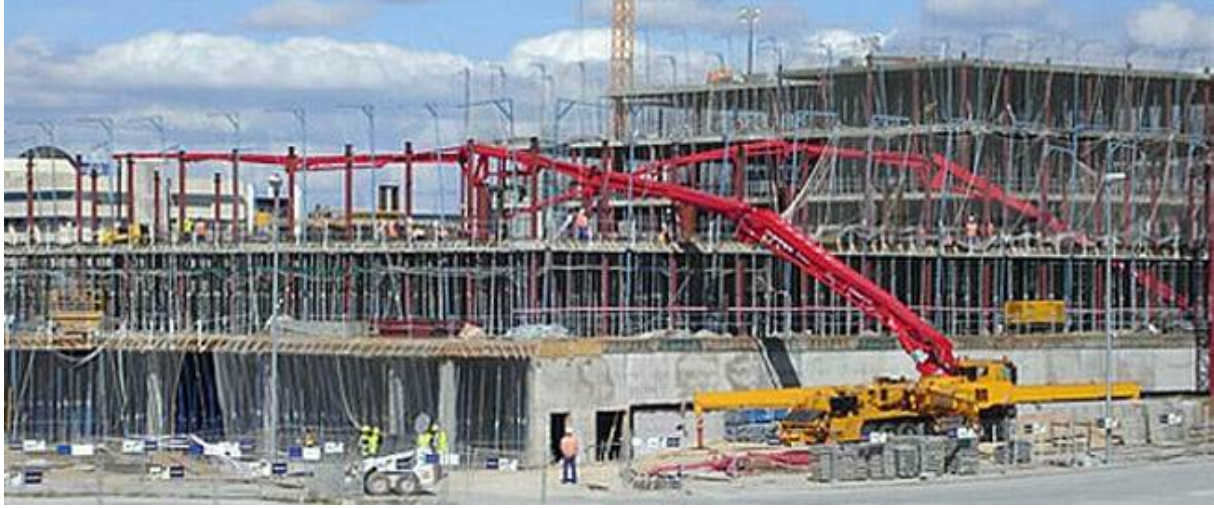
Şekil 2: Beton Dökümü
