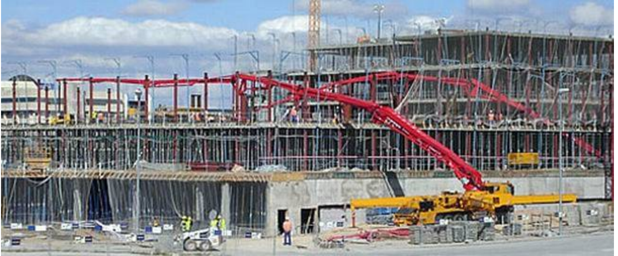
Şekil 1: Beton Dökümü
